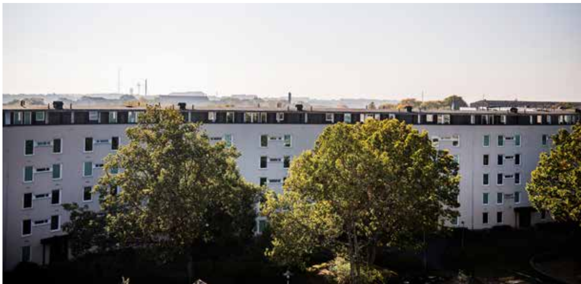
Ombyggnaden av halva taket på Månstenen i Kungsmarken har påbörjats.
